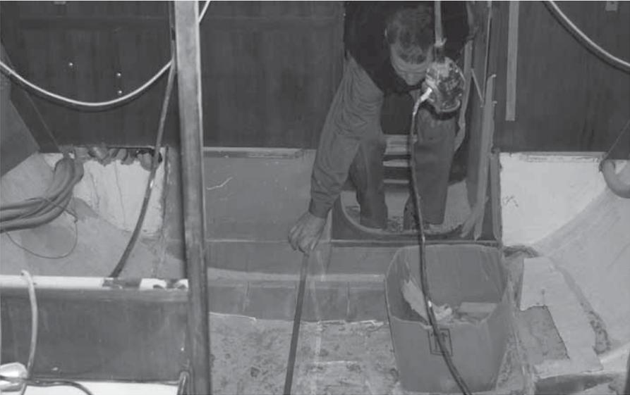
Kojenlängsschott und alte Bodenwrangen bis auf die vordere sind entfernt
