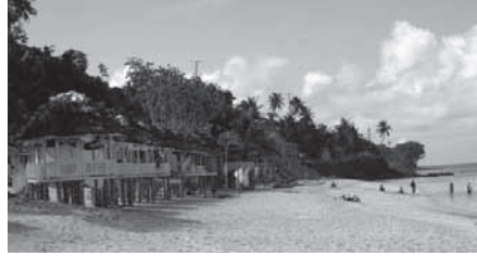
Süden Samoa, weißer Sandstrand, Süden von Tsunami beschädigt
